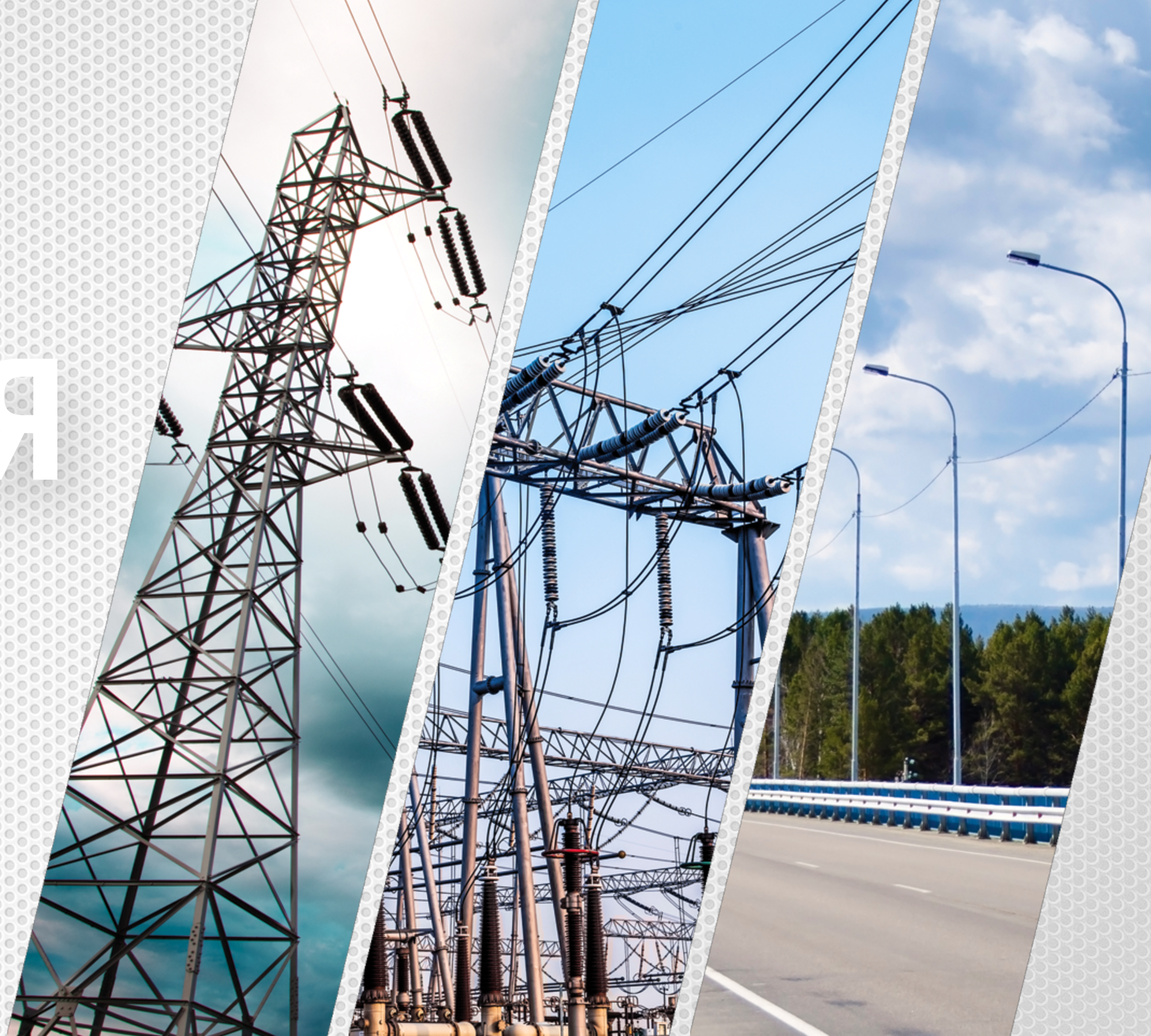
Высоковольтные линии электропередач
